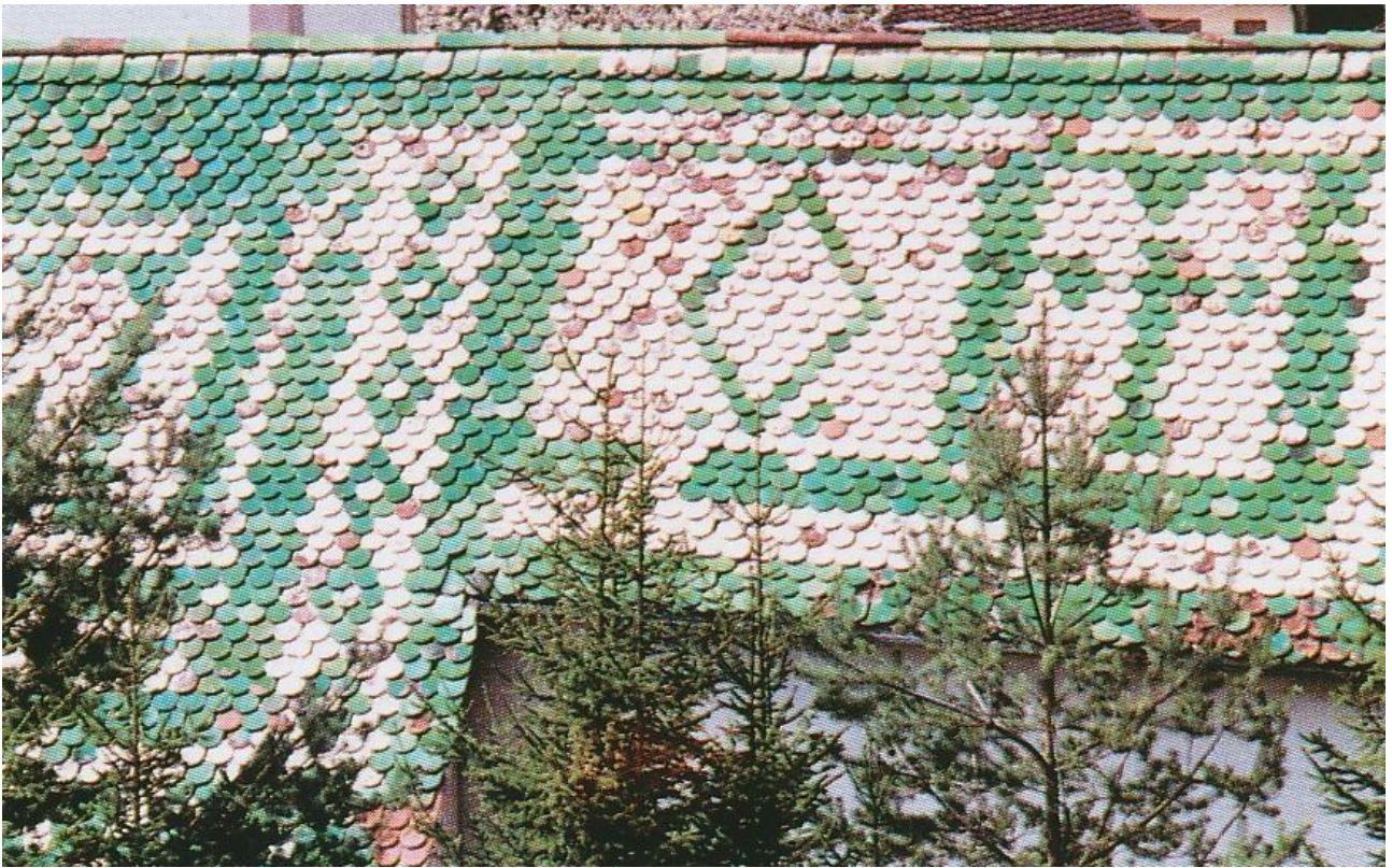
Figura 1: Chiesa di Liariis. Copertura in tegole verniciate.
